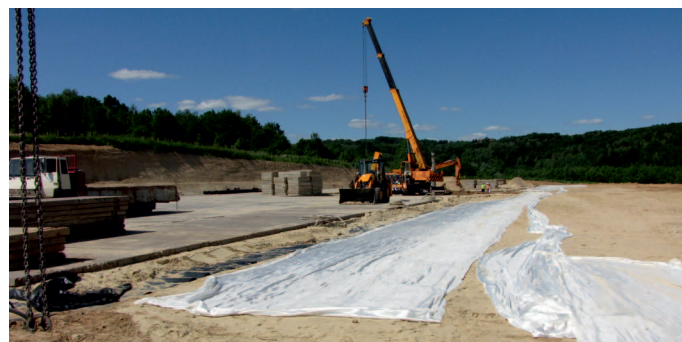
Rys. 1. Przykład wykonania fundamentu i placu wiertni z żelbetowych płyt drogowych z zastosowaniem geosyntetyków do wzmocnienia i uszczelnienia fundamentu przed migracją substancji ropopochodnych do gruntu (zdjęcie: K. Macnar)
