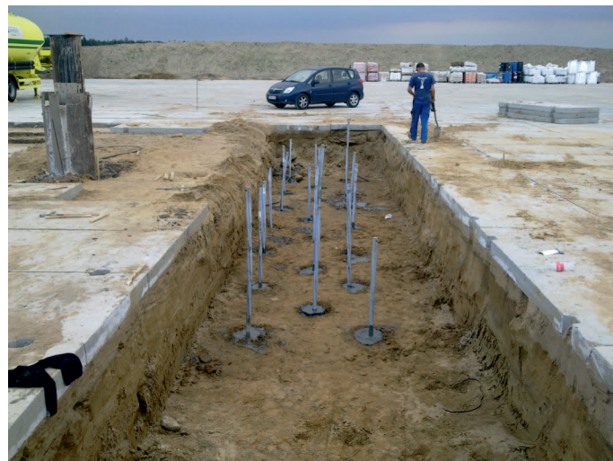
Rys. 6. Efekt końcowy montażu mikropali z pokrywą betonową i nadmiarem prętów do wycięcia (zdjęcie: M. Żak)
