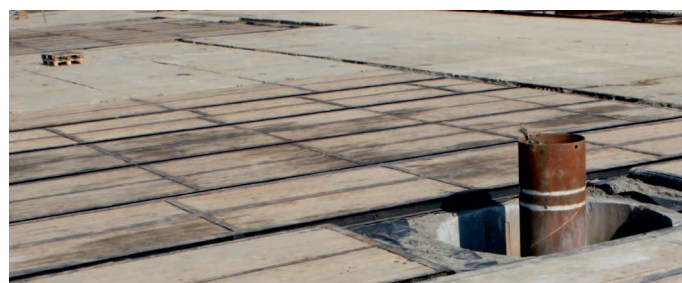
Rys. 2. Przykład fundamentów pod wiertnię wykonanych z płyt drewnianych z zastosowaniem geosyntetyków w celu uszczelnienia przed migracją substancji ropopochodnych do gruntu (zdjęcie: K. Macnar)
