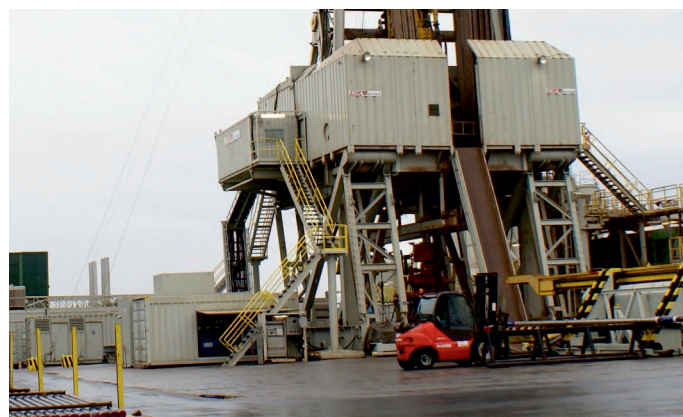
Rys. 4. Przykład fundamentu pod wiertnicę w postaci monolitycznej płyty żelbetowej wraz z placem manewrowo-magazynowym o nawierzchni asfaltowej (zdjęcie: S. Stryczek)
