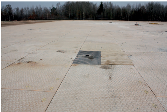
Rys. 3. Przykład fundamentu i placu wiertni wykonanego z płyt kompozytowych HDPE (zdjęcie: K. Macnar)
