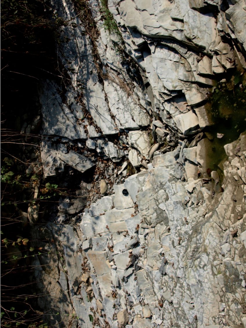
Fot. 50. Łukowe, Centralna Depresja Karpacka. Uskoki typu „radialnego” – proces kolapsu w obrębie CDK
